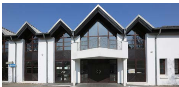
Fenster und Türen der Ulmenhalle werden erneuert – der Energieverbrauch soll danach sinken. Foto: Markus Kohz
