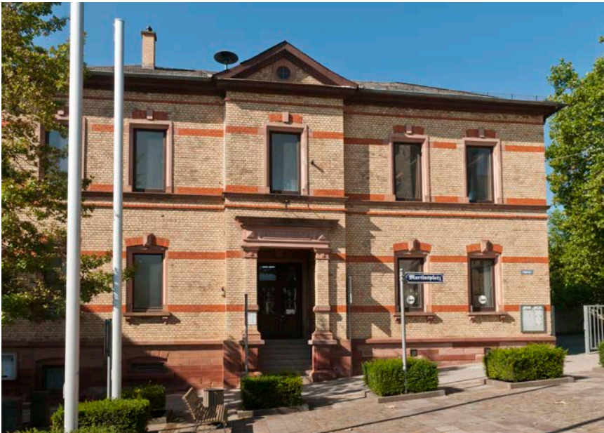
Großbaustelle Alte Schule. Bis 2017 soll das Gebäude saniert und für alle Ober-Olmer nutzbar sein. Foto: Markus Kohz
