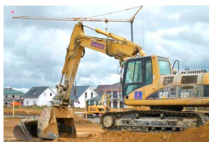
Die Bagger prägen das Bild im Baugebiet Pfannenstiel. Foto: Bardo Faust
